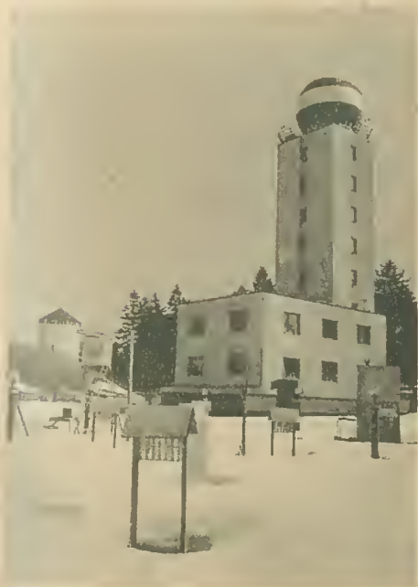
Bild 3 Die Wetter-Radar-Station auf dem Bornhügel bei Neuhaus/ Rennweg
