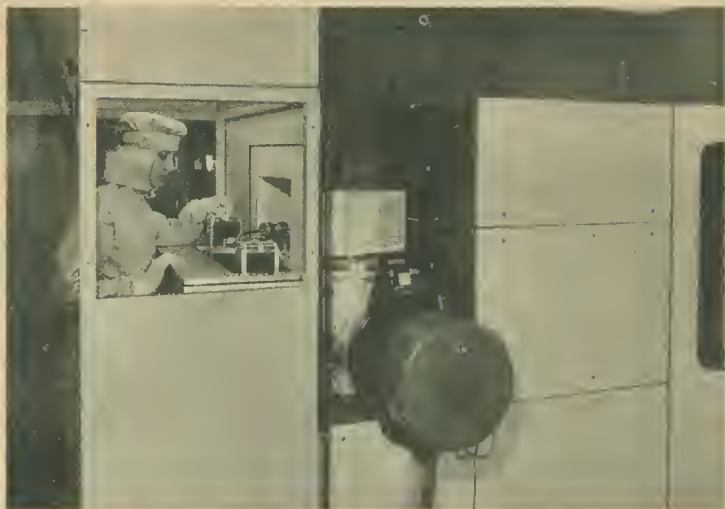
Bild 4 Schaltkreise in der 1,5- \mu m-CMOS-Technik werden auf Zeiss-Anlagen produziert, das Foto zeigt die Ionenstrahl ­ l ­ atzanlage ISA 150 f ­ ur 125-mm-Scheiben (Foto: RFT-Pressediens ­ t)
