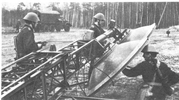
Bild 5 Die Hebevorrichtung mit den Antennen wird mon- tiert
