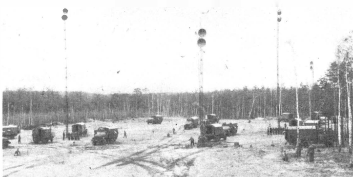
Bild 6 Aufbau von Richtfunkstellen
