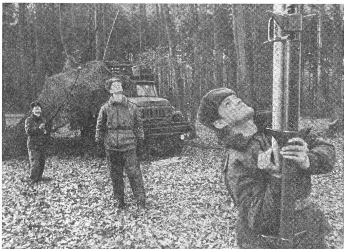
Bild 4 Aufbau des 12-m-Dipolsendemastes für Stationen mittlerer Leistung, bestehend aus 10 Teilen je 1,20 m Länge
