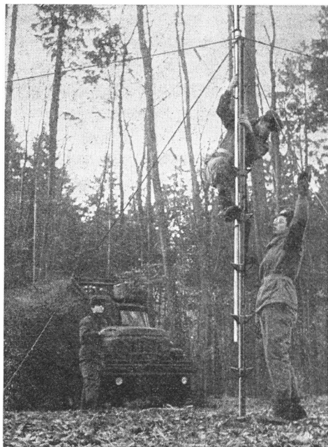
Bild 3 Das Einhängen der Dipolspeiseleitung wird vorbereitet
