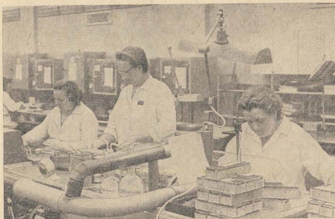
Bild 3 Kontaktierung von Germaniumtransistoren
