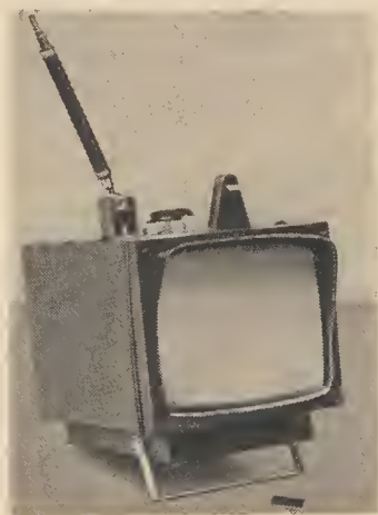
Bild 2 Mit integrierten Schaltungen bestückt ist der kleine Fernsehempfänger Integral von W. Samoilkow
