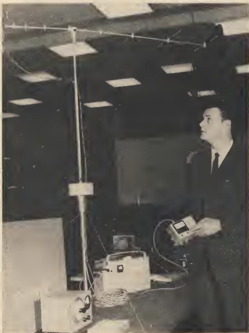
*Der UKW- und Dezimetertechnik verschrieben hat sich Dipl.-Ing. H. Kuhl, DM 2 CFL. Hier erklärt er seine fernbedienbare Yagi-Antenne für das 70-cm-Amateurband. Rechts daneben sein transistrieretes Funksprechgerät für das 2-m-Amateurband, dem ein Varaktor-Verdreifacher sendeseitig für das 70-cm-Band nachgeschaltet ist. Für den Empfang auf 70 cm befindet sich im gleichen Zusatzgehäuse ein Transistorkonverter, der die Signale in das 2-m-Band umsetzt*
