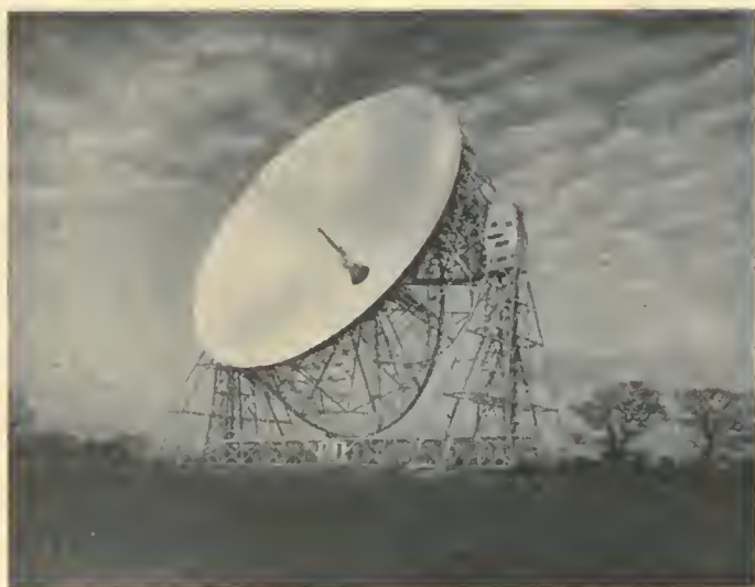
Foto B 250-ft-(75-m-)Radioteleskop der Universität Manchester in Jodrell Bank, Cheshire, England. Es ist ein nach allen Richtungen — in Azimut und Höhe — einstellbares Radioteleskop. Sein Gewicht beträgt 750 t.
