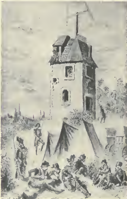
Bild 2 Station einer optischen Telegrafienlinie nach Chappe
