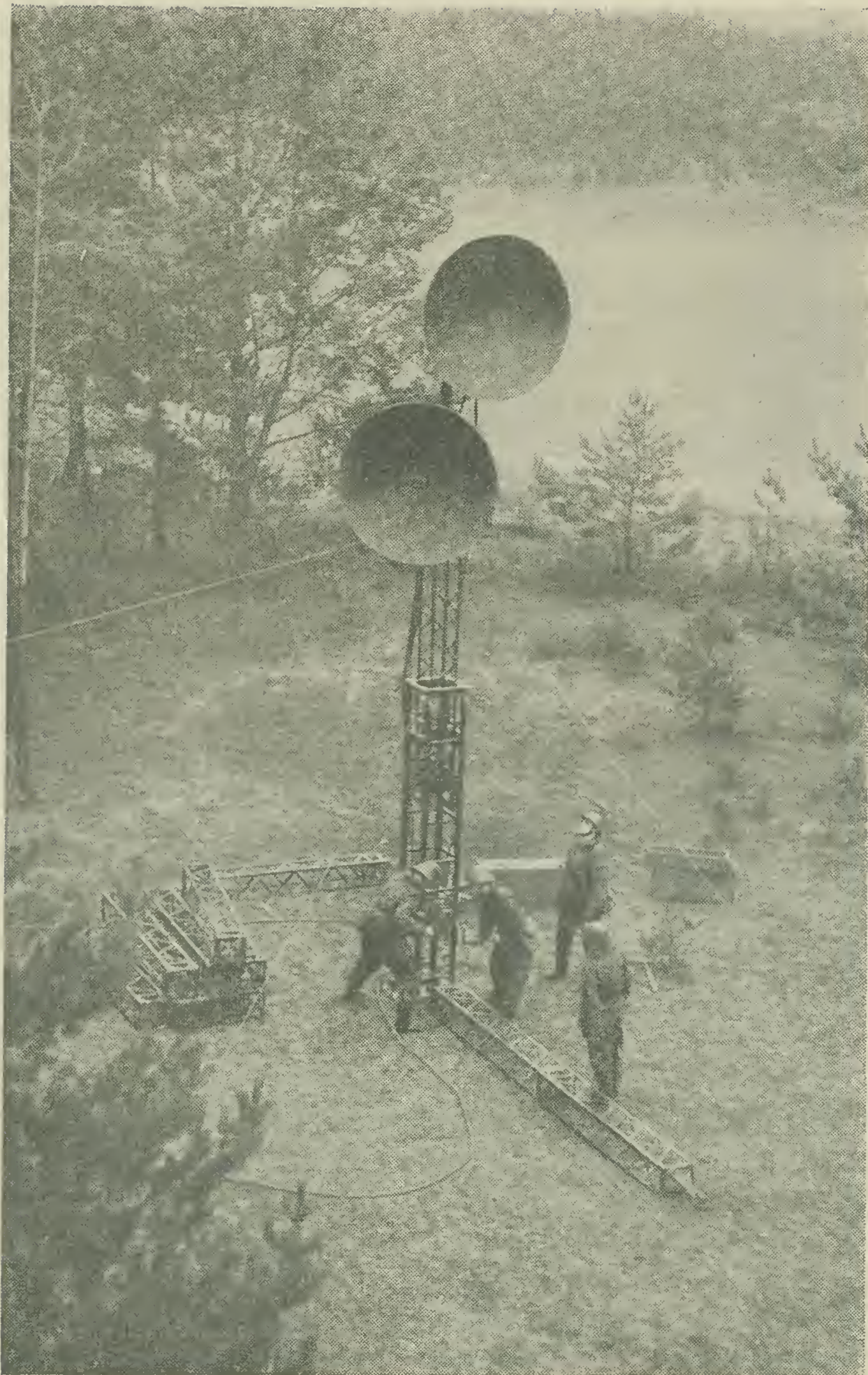
Bild 3 Eine moderne Armee wie unsere NVA verfügt auch über Richtfunkgeräte. Unser Bild zeigt das Aufrichten eines Antennenmastes
